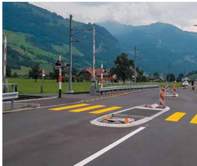
Oberdorf: verbesserte und sicherere Fussgängerquerung im Bau
